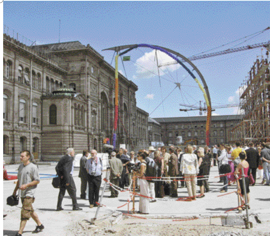
Le hall des transports - La pose du premier arc du hall des transports, le 10 juillet dernier, marque le démarrage de la construction de la verrière qui recouvrira une vaste salle de 2 000 m 2 . Longeant le bâtiment des voyageurs, cette verrière sera soutenue par dix-huit arcs. Ce défi de verre et d'acier permettra de doubler la surface de circulation disponible tout en préservant un patrimoine architectural unique.
