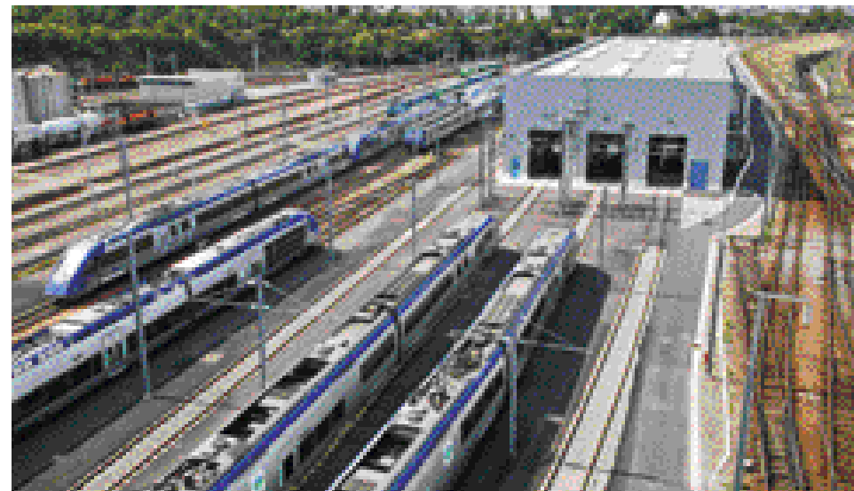
L'extension de l'atelier ZTER de Rennes vise un double objectif : conforter l'emploi sur le site et optimiser la maintenance. Les collectivités ont investi 6 millions d'euros dans ce projet majeur.
