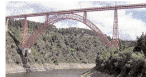
Le viaduc de Garabit
