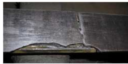
Défaut d'écaillage identifié
