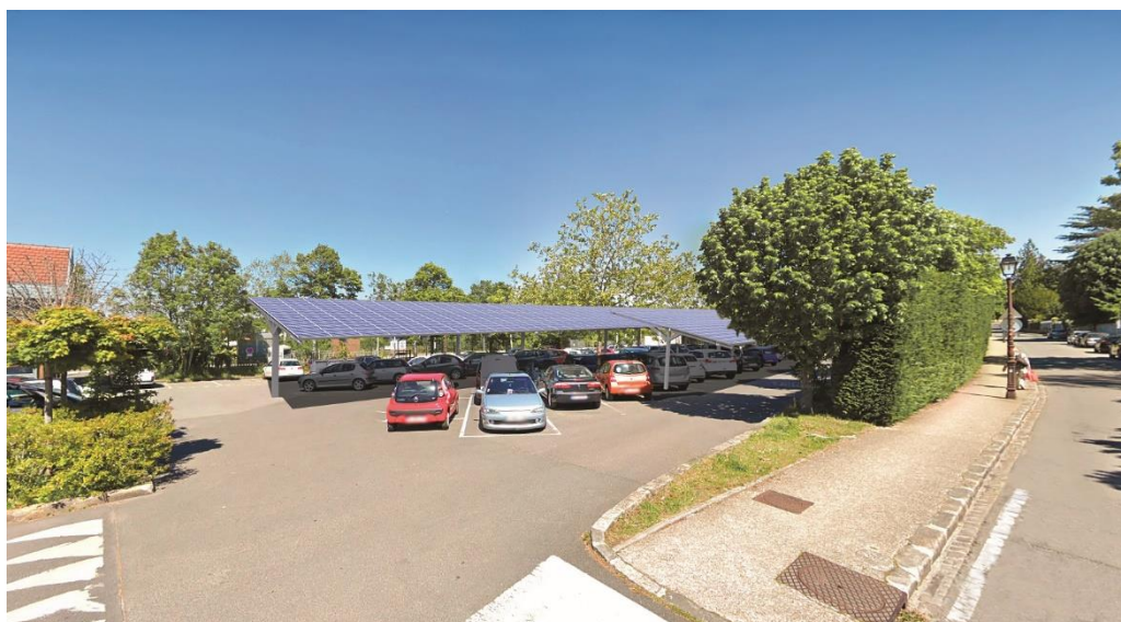
Futur parking de la gare de Louveciennes (Ile-de-France)
